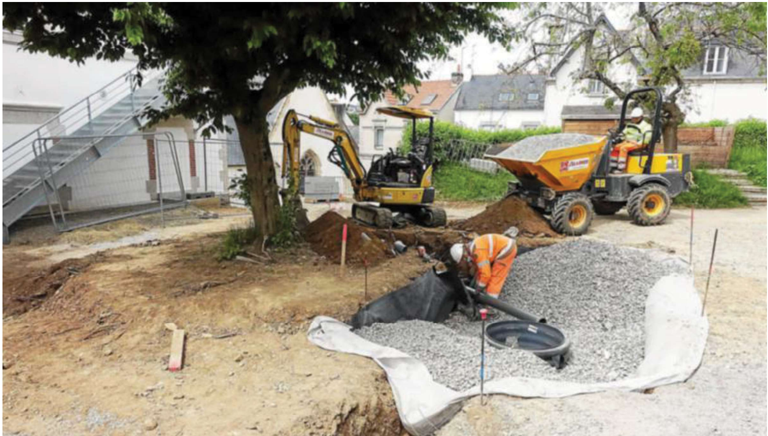
Les puisards filtrants, installés dans le jardin de Kerjégu, permettront d'évacuer les eaux de pluie vers la nappe phréatique.
