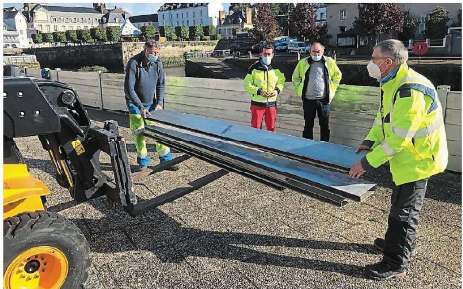
Mise en place des barrières anti-crues, mardi matin, sur le quai Brizeux.
