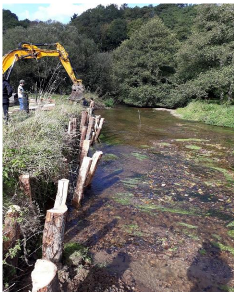
Restauration des berges du Jet avec des fascines – Maitrise d'ouvrage : Sivalodet
