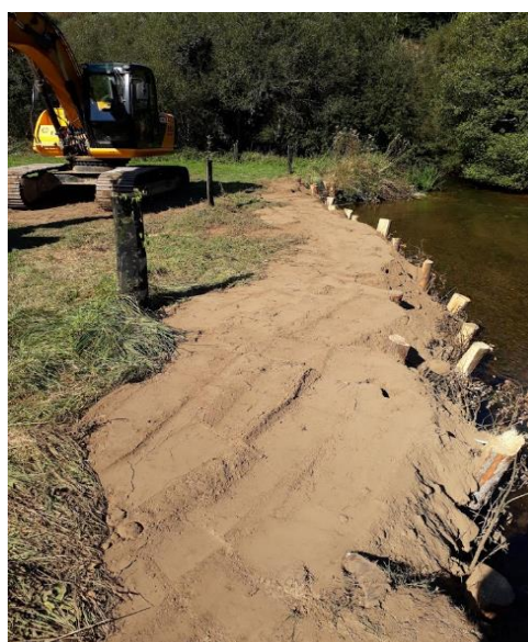
Restauration des berges du Jet avec des fascines – Maitrise d'ouvrage : Sivalodet
