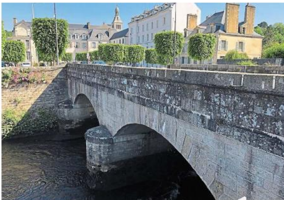
Le pont du Bourgneuf, au cœur d'une étude dans la lutte contre les inondations à Quimper.
