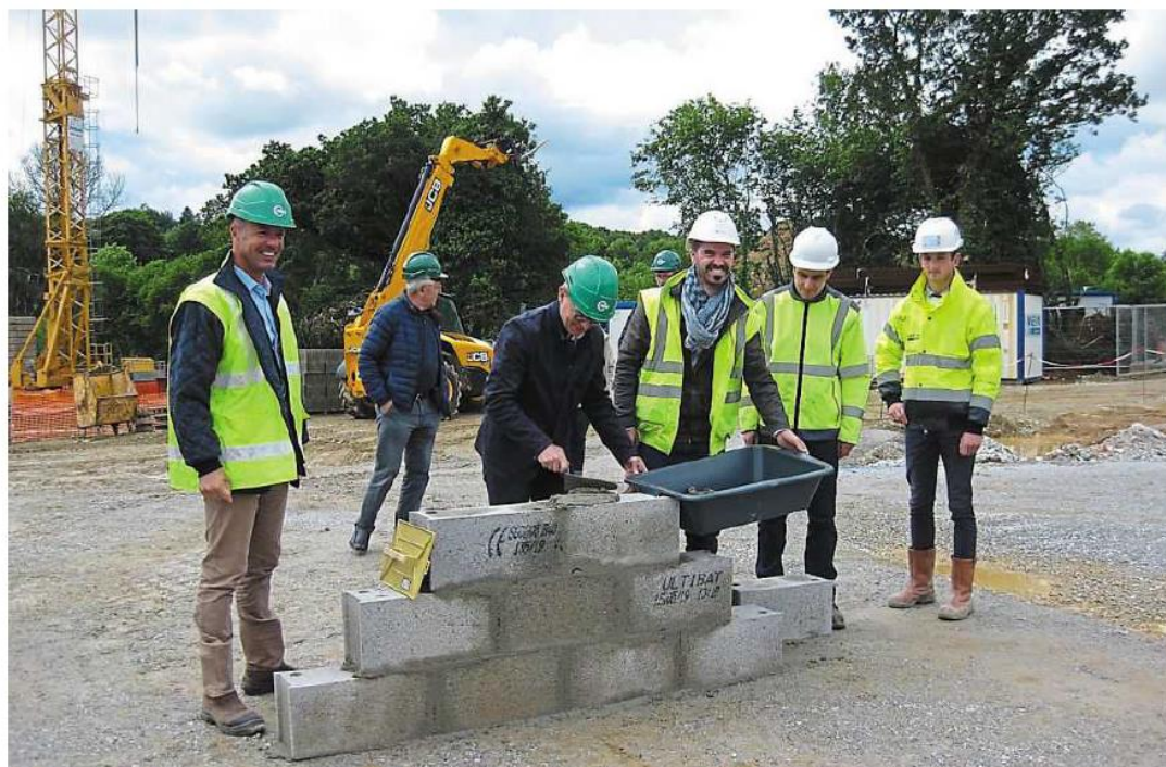
Le maire, David Le Solliec, a lancé les travaux de la station d'épuration, en posant les premières pierres.
