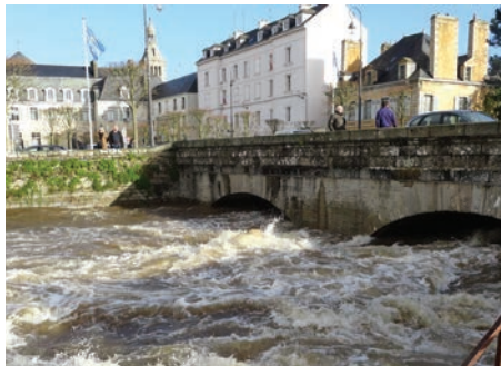
Pont du Bourgneuf lors des crues de 2013/2014 (06/02/2014)
