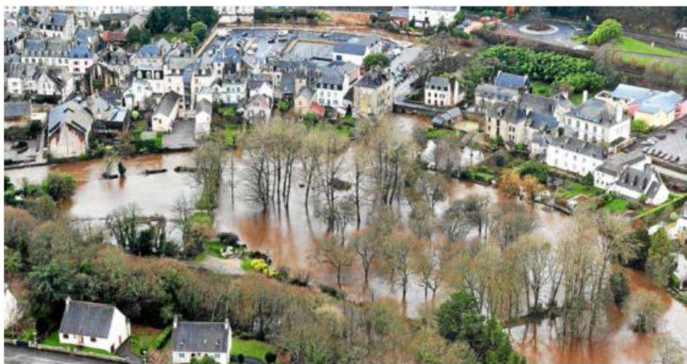
Afin de protéger le secteur des Anciennes Fonderies, ici lors de la crue de janvier 2014, la Ville envisage la réalisation d'une digue en remblai ou d'un mur anti-crues. (Photo archives : Claude Prigent)
