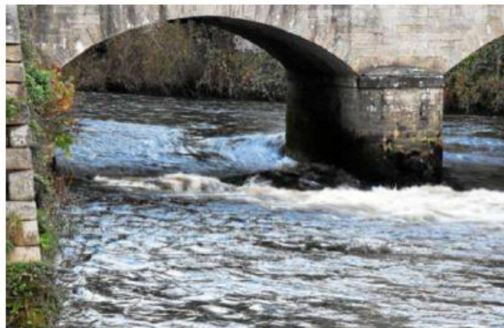
La société ISL Ingénierie va étudier le bénéfice qu'il pourrait y avoir à modifier la configuration du pont du Bourgneuf, propriété du Département.
