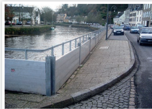
Barrières anti-inondation du Quai Brizeux à Quimperlé
