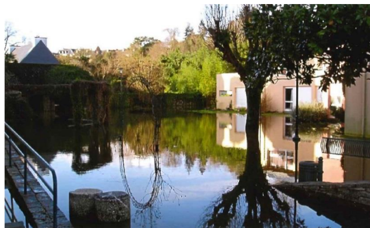
Photo 46 et Photo 47 : 07/02/2014, 10h environ ( 3h après le pic de crue de l'Isole ) : Débordement localisé de l'Isole sur le site de logements HLM / Habitat 29 (Source : DLB, Ville Quimperlé)
