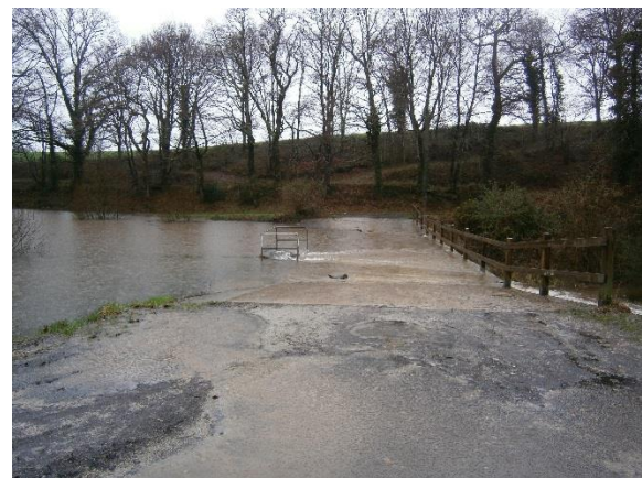
Photo 24 : Ouvrage de « Kerglancharde » sur le Dourdu lors de la crue de février 2014 (Ville Quimperlé, 11/02/2014)
