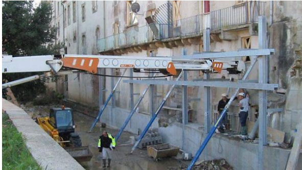
Photo 59 : confortement provisoire des maisons rive droite riveraines de l'Isole (2014)
