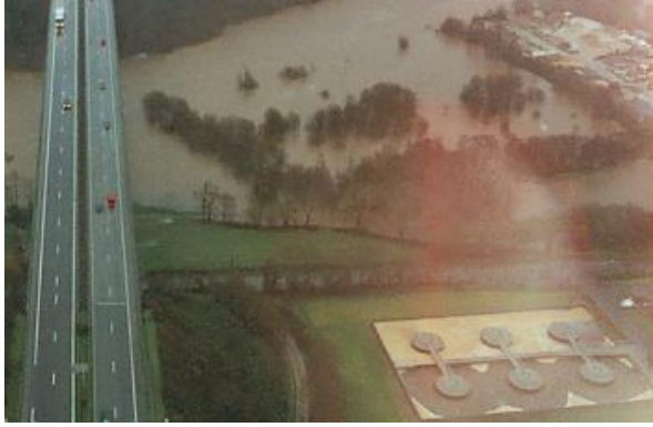
Photo 17 : Station d'épuration de Quimperlé, en bordure de la Laïta (lors de la crue de 2000)
