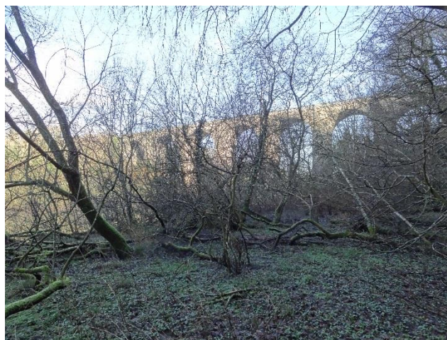
Photo 1: Atterrissements végétalisés en limite de lit mineur et majeur de la Laïta, à l'aval immédiat du pont SNCF (SMEIL, 19/01/2015)
