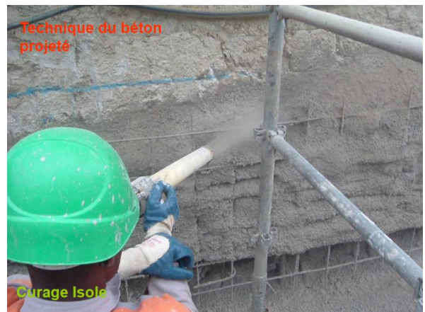
Photo 35: technique de Jet Grouting et Photo 36 : technique du béton projeté sur les fondations
