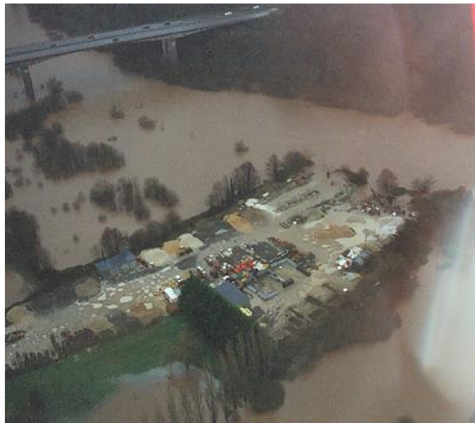
Photo 2 : Remblais en lit majeur de la Laïta, à l'aval de la RN165 (12/2000)
