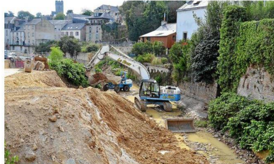
Photo 60 : travaux de consolidation des berges rive gauche de l'Isole (2014)
