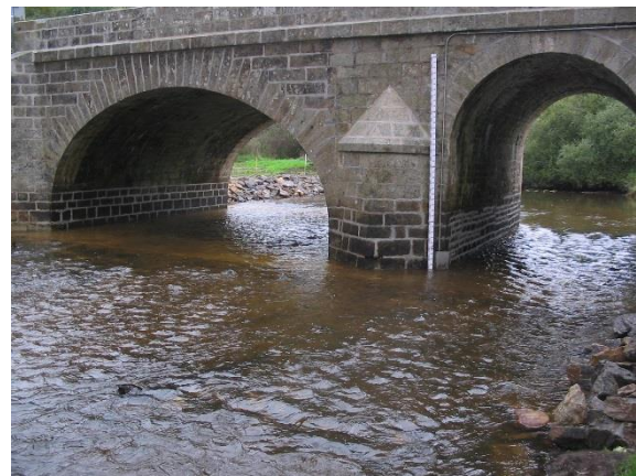
Photo 15 : L'échelle limnimétrique et le capteur du Pont Croac'h sur l'Isole, 10 Km en amont du site (PDM)
