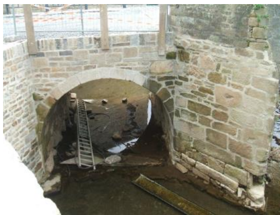
Photo 41 : Ré-ouverture d'une 4 ème arche sur le pont Fleuri sur l'Ellé
