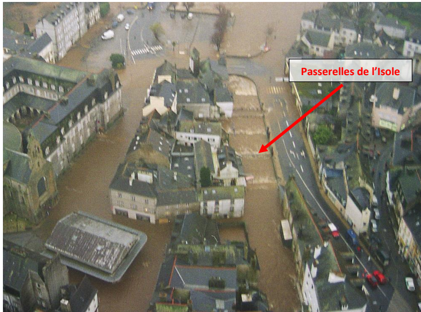
Photo 52 : 06/01/2001, soit le lendemain du pic : les passerelles sur l'Isole sont en charge, les halles et la rue de la Paix sont inondées (Source : survol hélicoptère Sécurité civile, archives Ville Quimperlé)
