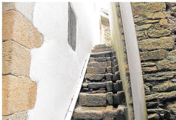
Certaines maisons du quai Brizeux possèdent une évacuation historique pour pouvoir passer par-derrière et rejoindre la haute-ville en cas d'inondations.
