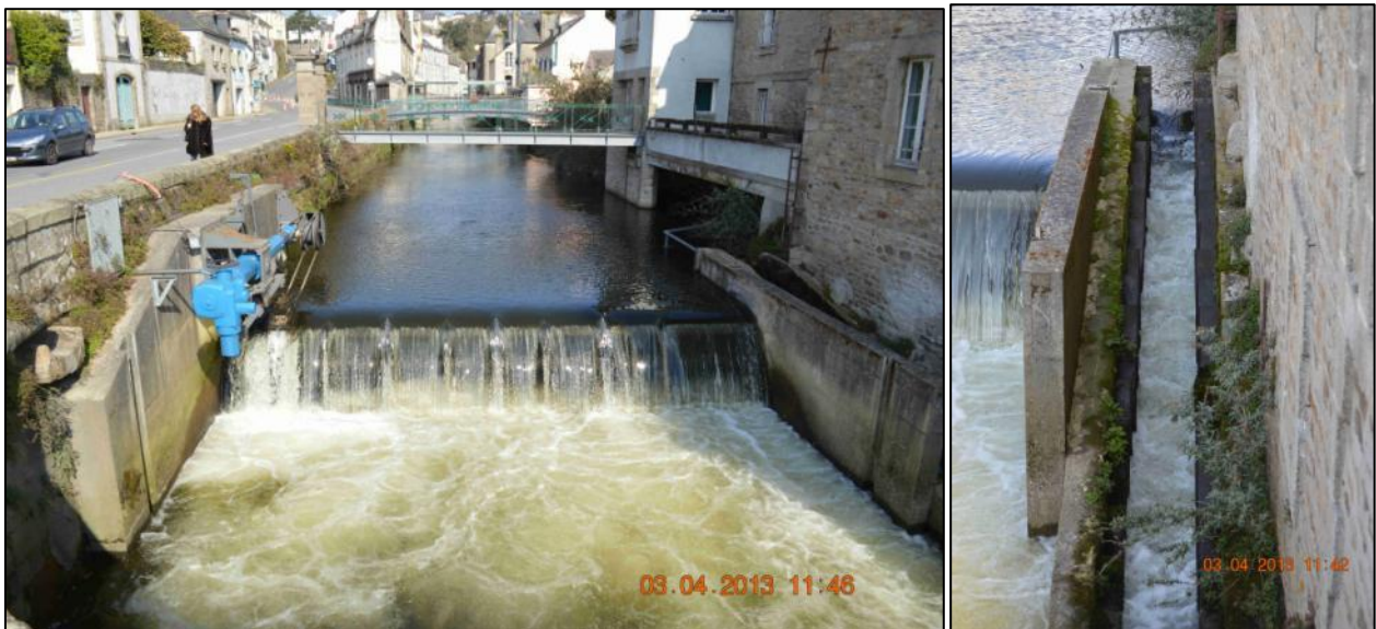
Figure 52 - Clapet mobile et sa passe à poisson sur l'Isle à Quimperlé en amont du pont fleuri. Prises de vue du 03/04/13 par In Vivo.
