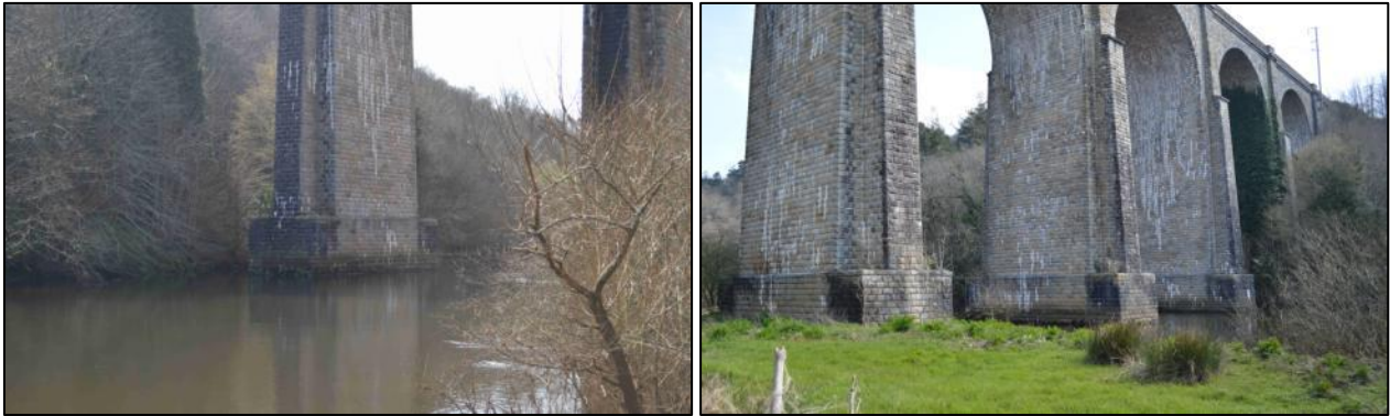
Figure 61 - Piliers du viaduc ferroviaire. Prises de vue du 03/04/13 par In Vivo.
