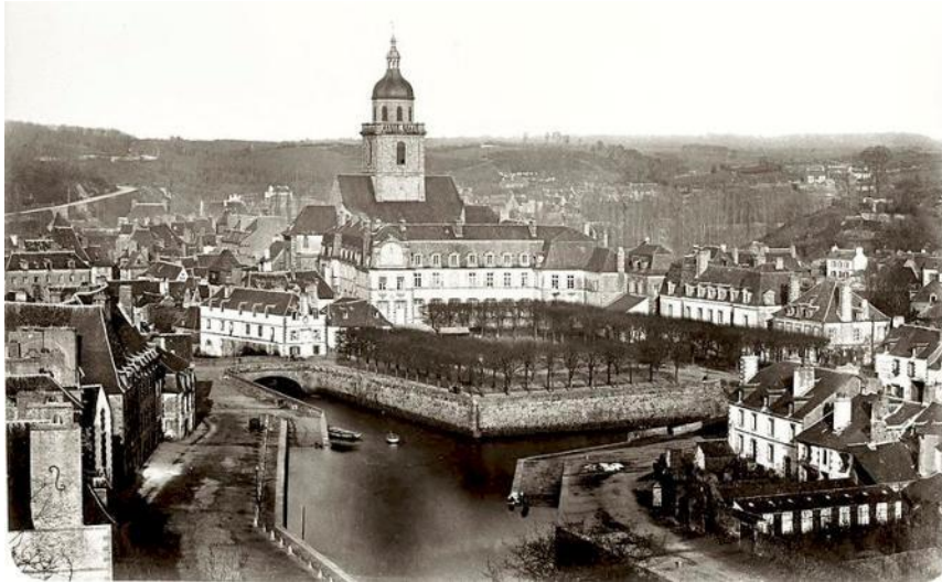
Figure 51 - L'abbaye Sainte-Croix avant l'effondrement du clocher en 1862 (wikipédia).
