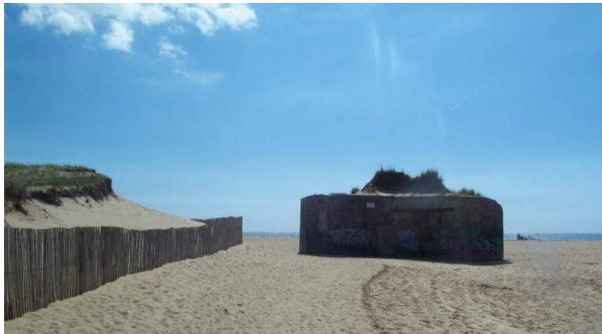
Figure 64 - Blockhaus situé à l'extrémité de la flèche dunaire ; Photographie du 31 août 2004 (IN VIVO, 2005).
