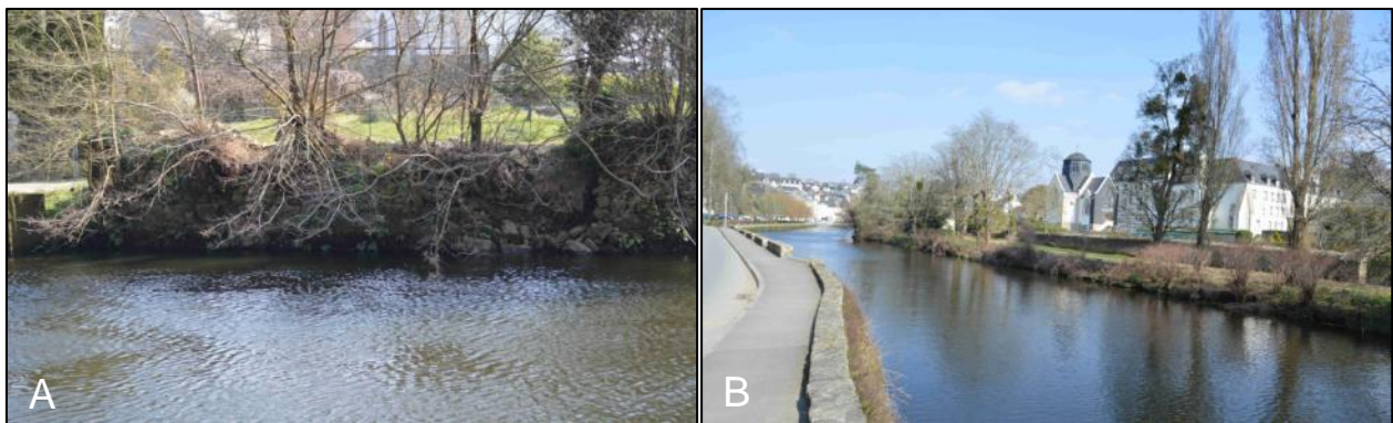
Figure 54 - Aménagements des berges en aval de Quimperlé centre, en rive gauche (A) et rive droite (B).
