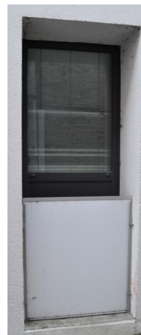
Figure 22 : batardeau installé par un habitant de Quimperlé devant sa porte
