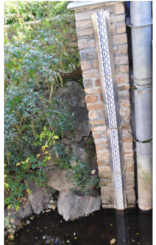
Figure 16 : Echelle de crue.
